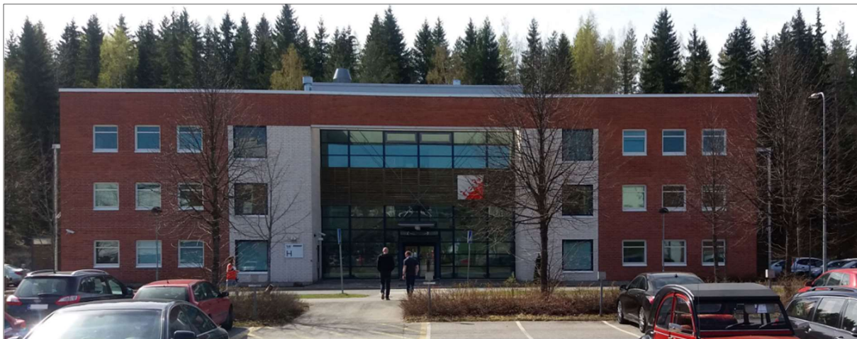
Kuva 19. H-rakennuksen pohjoisjulkisivu kesällä 2018.
