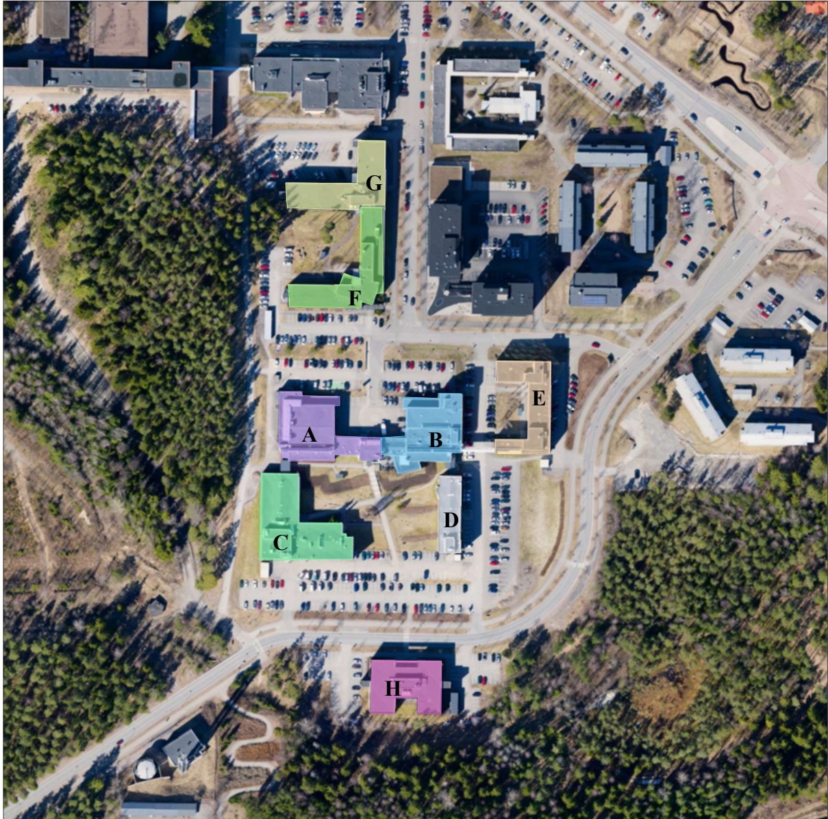
Kuva 9. IVH Kampuksen rakennuskanta suunnittelualueella ja sen ympäristössä.
