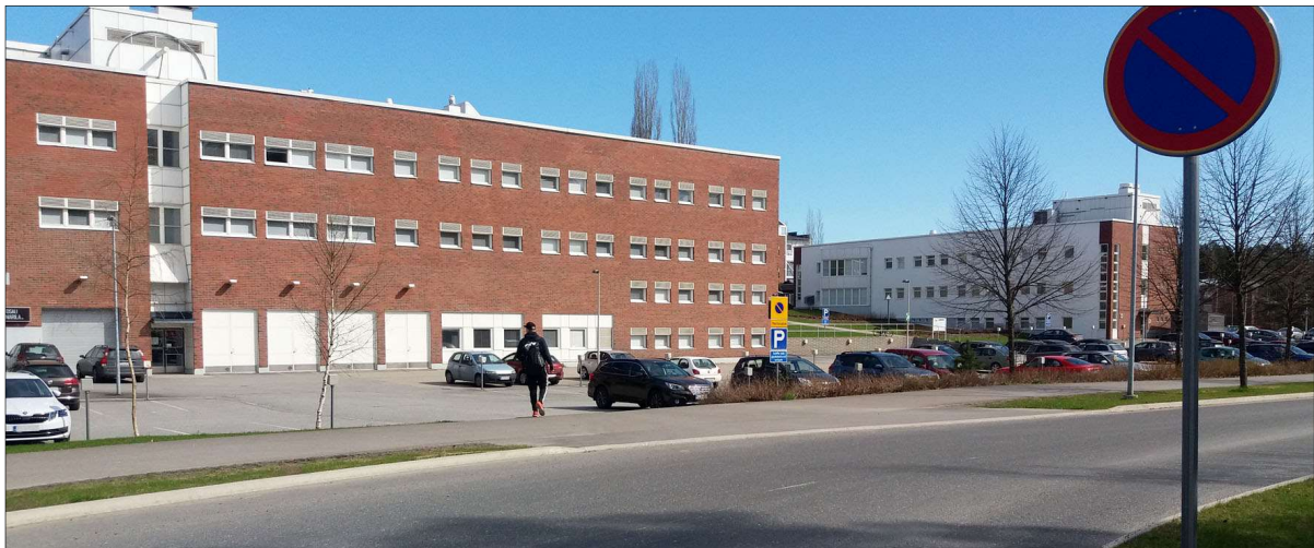
Kuva 13. Rakennus C ja taustalla rakennus D Teknoliapiuistonkadulta kesällä 2018.
