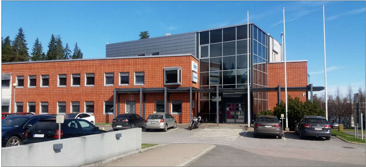
Kuva 17. F-rakennuksen pääsisäänkäynti ja pohjoisjulkisivua kesällä 2018.
